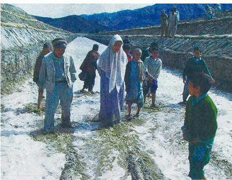
アフガニスタン東部に建設したマルワリード用水路で、完成した区間の通水を喜ぶ藤田さん(中央)と中村哲さん(左)。子どもたちはしゃべり回って来て=2005年3月(PMS提供)
